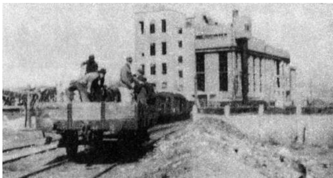
Widok elektrowni od strony boczniczy kolejowej, 1946 rok
