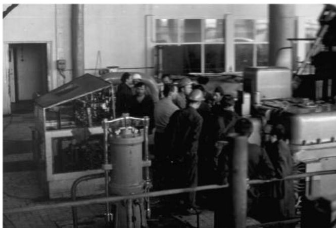
Rozruch turbiny nr 1, 22,5 MW, 1971 rok
