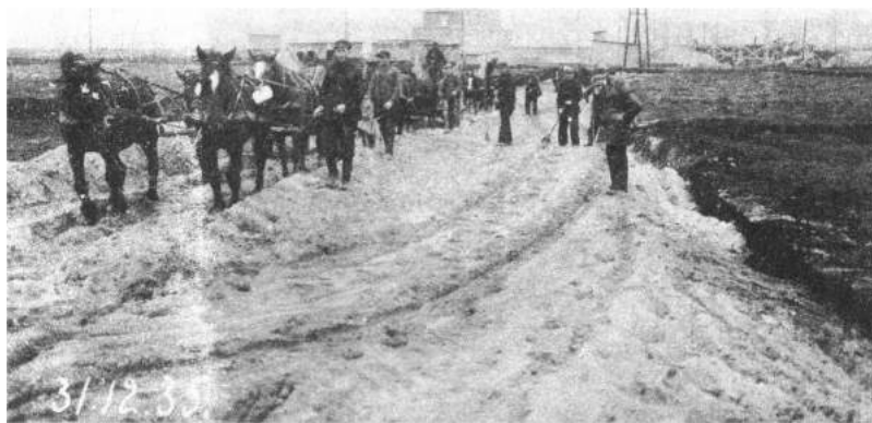
Budowa bocznic kolejowej dla elektrowni
