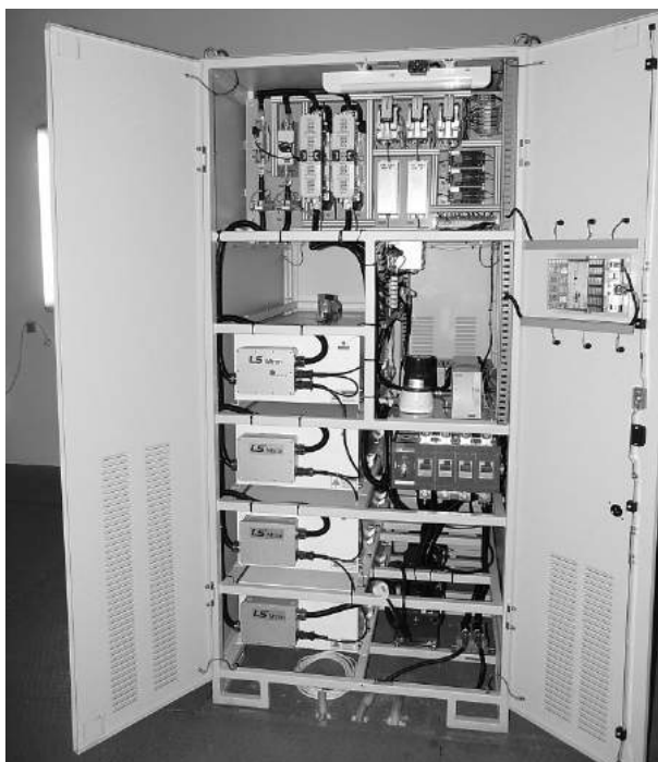
Podstacyjny superkondensatorowy zasobnik energii
