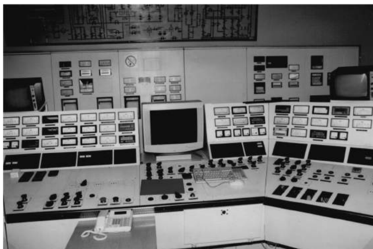
Zmodernizowany pulpit sterowniczy bloku 3, 1998 rok
