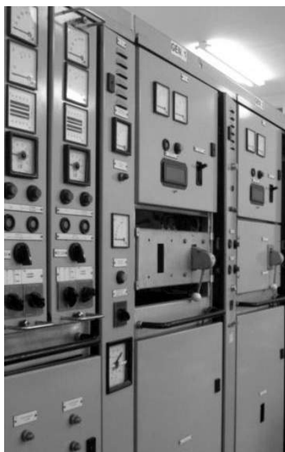
ELMOR – modułowa rozdzielnica niskiego napięcia typ RG 103 (laboratorium elektroenergetyki okrętowej Akademii Morskiej w Gdyni)
