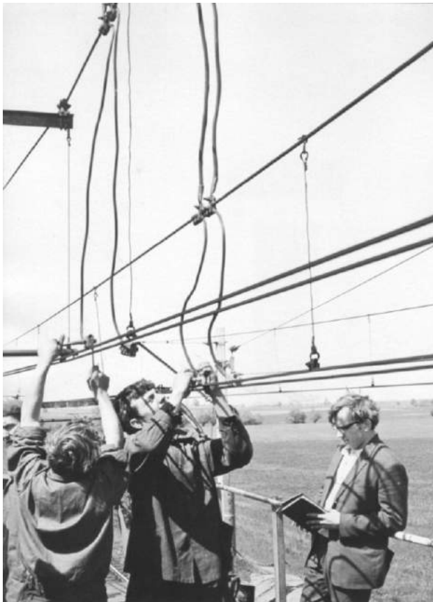
Prace przy górnej sieci trakcyjnej
