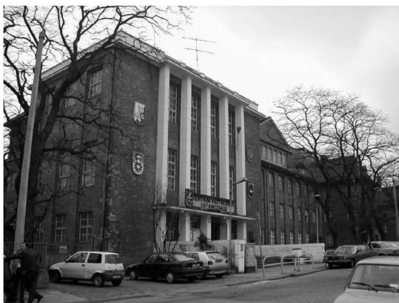
Budynek Centrum Kształcenia Ustawicznego im. Marszałka Józefa Piłsudskiego [5]
