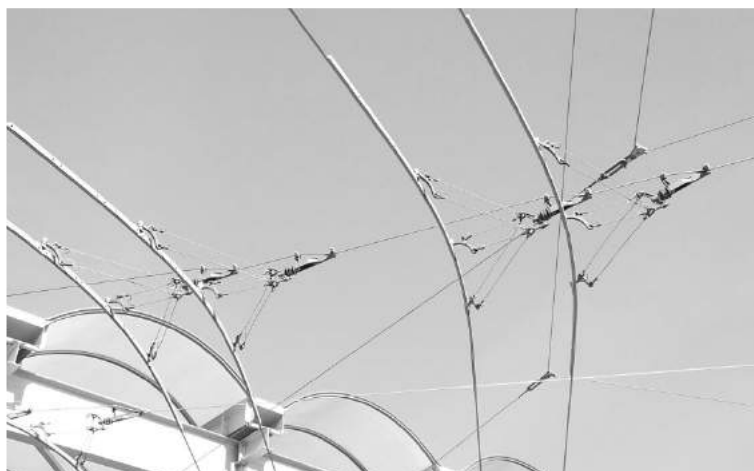
Sieć trakcyjna w nowej zajezdni trolejbusowej
