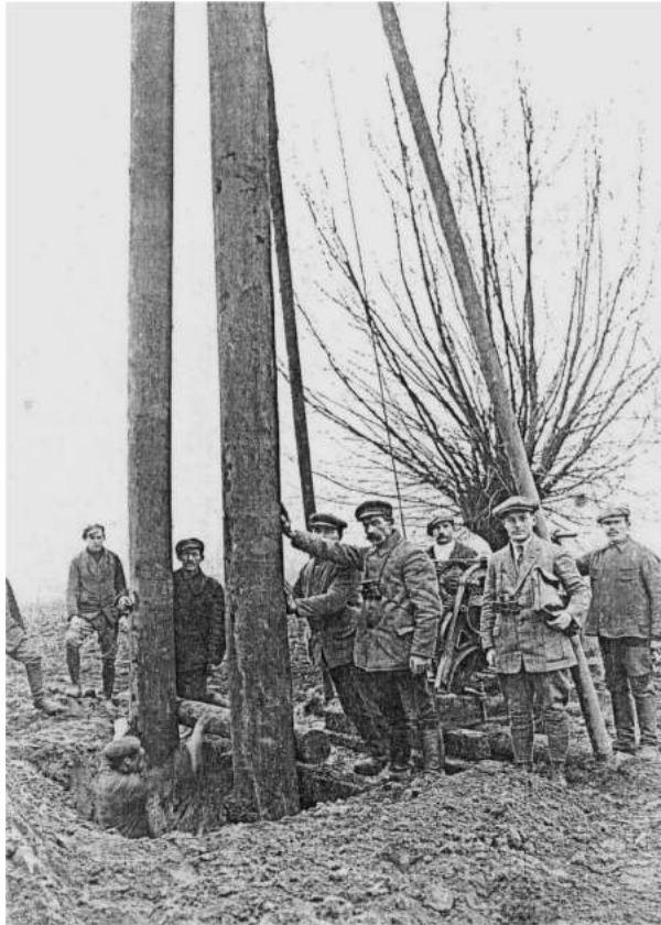
Budowa linii elektrycznej; Kazimierz Bieliński drugi od prawej [1]
