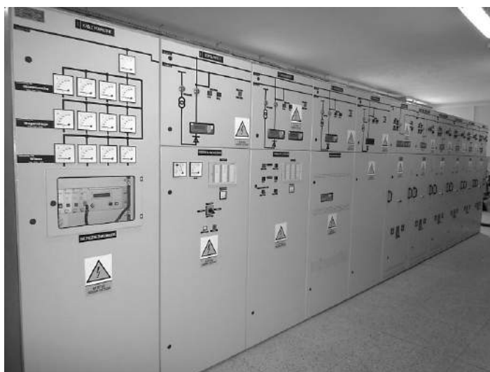
Nowoczesna podstacja trakcyjna komunikacji tramwajowej w Gdańsku
