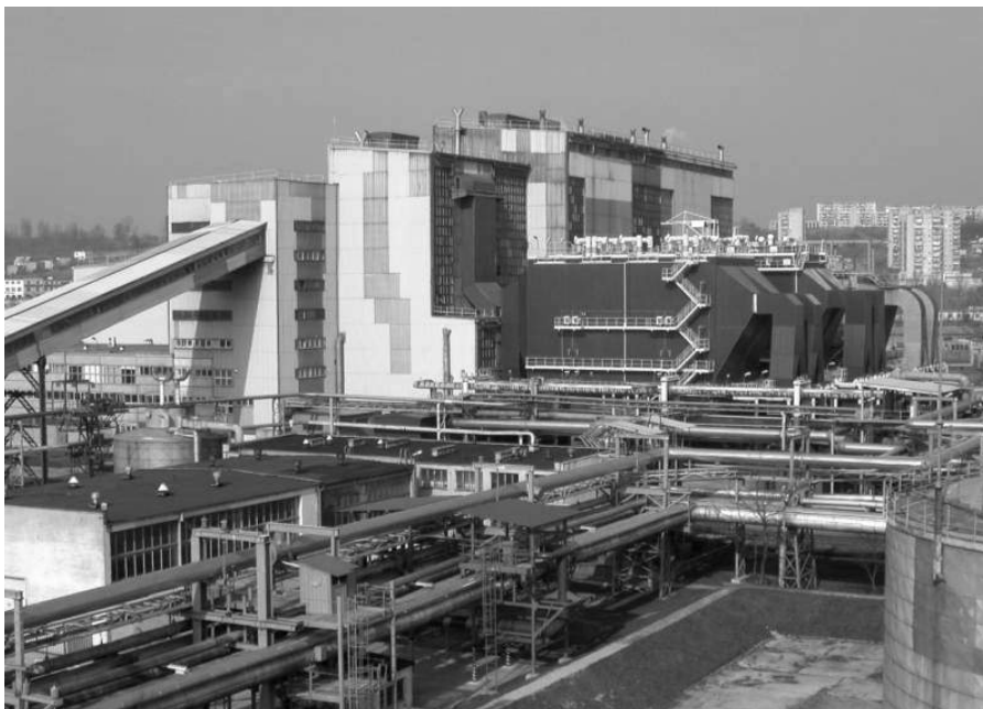
EC 3, widok na elektrociepłownię, 2005 rok
