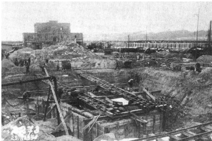
Czwarty miesiąc budowy elektrowni; na pierwszym planie fundamenty pompowni wody morskiej
