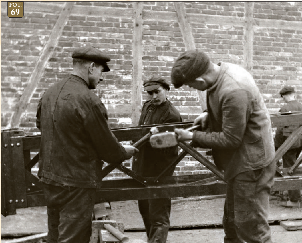
Fot. 69 – Nitowanie stupa kratowego dla linii 60 kV Gródek – Grudziądz. Zdjęcie wykonano latem 1928 r.
