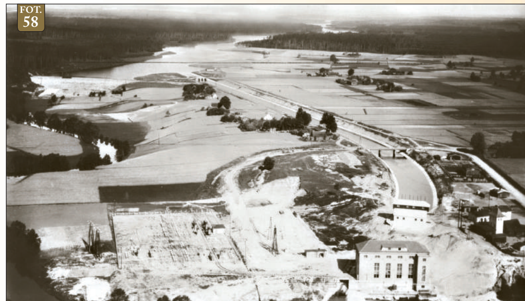
Fot. 58 – Obiekty Elektrowni Żur z lotu ptaka. Widoczny budynek hali maszyn, rozdzielnia napowietrzna, zamek wodny, zapora, kanał i zbiornik. Lata 30. XX w.
