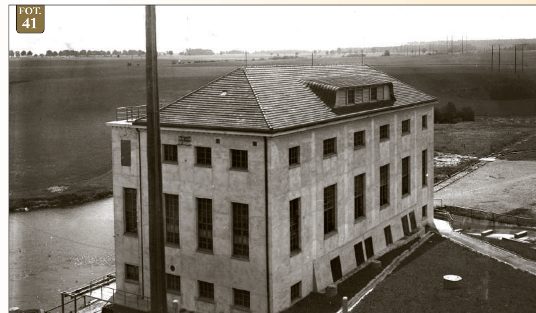
Fot. 41 – Budynek hali maszyn Elektrowni Żur, lata 30. XX w.
