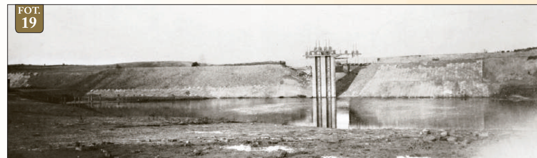
Fot. 19 – Budowa zapory w Gródku – widoczny wał z filarem zasuw, obecnie pod wodą – 29 listopada 1920 r.
