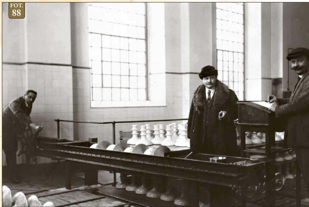
Fot. 88 – Próbnym naciąganiem czterech ogniw izolatorów typu Hf-35 siłą 4 kg za pomocą dynamometru 20-tonowego pod nadzorem inż. Alfonsa Hoffmanna
