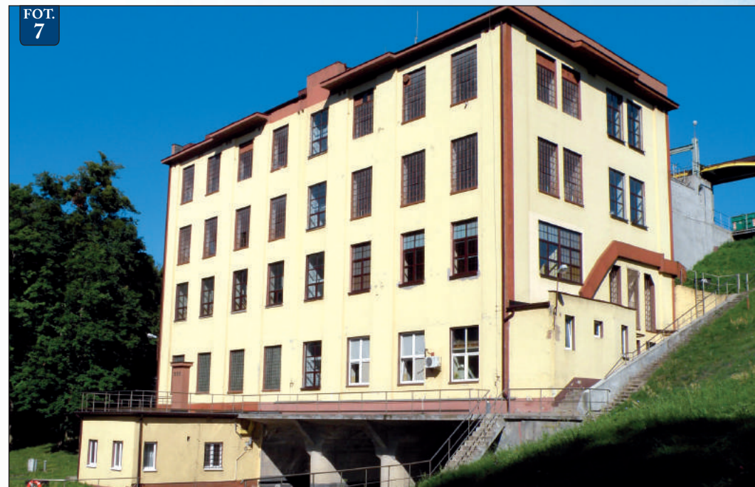
Fot. 7 – Budynek hali maszyn Elektrowni Wodnej Gródek od dolnej wody
