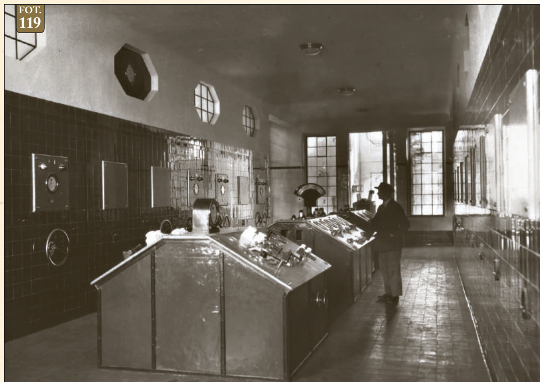
Fot. 119 – Nastawnia Podstacji 60 kV/15 kV PEK „Gródek” w Gdyni, w sierpniu 1928 r.
